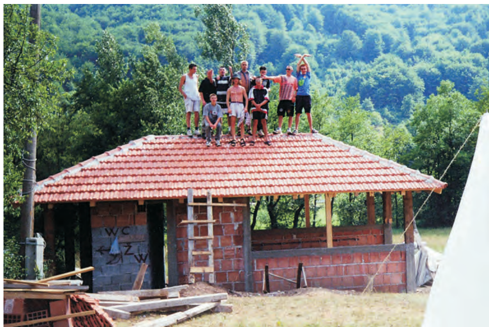
1999. - Izgradnja WC-a u kampu na Boražkom jezeru
